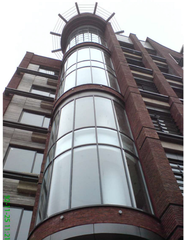
ساختمان مسکونی آقای عسگری، سعادت آباد
