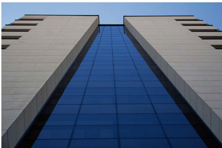
پروژه اداری عطار
